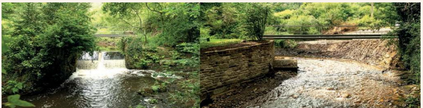
L'ancien point de blocage a été supprimé pour recréer un radier
